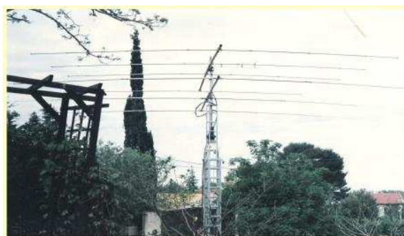
Antennes Beams monobandes (grand espacement), Le pylône est un CTA T/12 3 télescopique, sans haubans.
