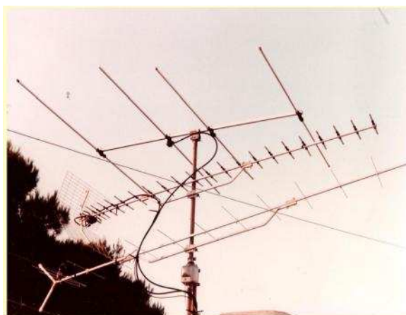
Antenne VHF, télévision et 50MHz fixé sur une cheminée avec un cerclage
